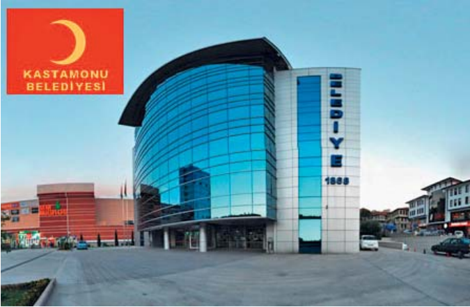
Şekil 1. Kastamonu Belediyesi binası
