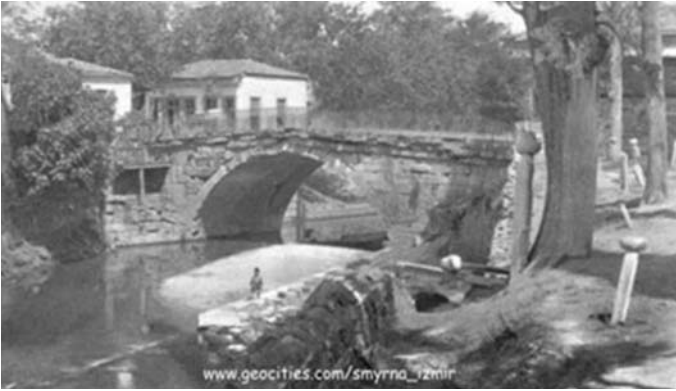
Şekil 2. Buca Kervan Köprüsü (İzmir Valiliği, 2016)
